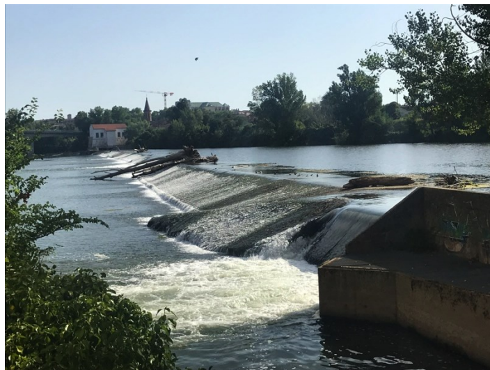
Vue du seuil de Sapiac
